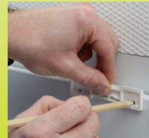
Abb. 1: Fensterflügel-Halterung (C) anlegen und Bohrlöcher anzeichnen
