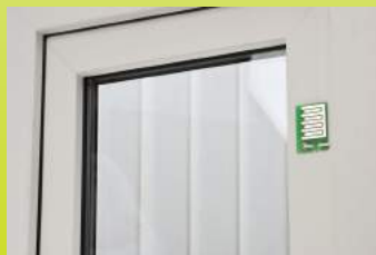
Abb. 32: Fertig fixierter Regensensor
