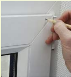
Abb. 14: Position der Bohrung für die Umlenk-Rolle markieren
