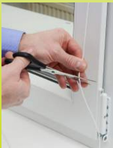
Abb. 19: Kürzen der Entriegelungsschnur auf die gewünschte Länge
