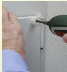
Abb. 16: Anschrauben der Umlenk-Rolle
