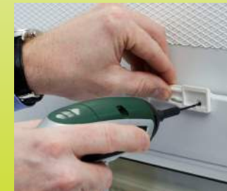
Abb. 2: Löcher am Fensterflügel vorbohren
