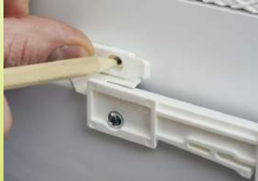
Abb. 5: Position der Schrauben für Fensterrahmen-Halterung markieren
