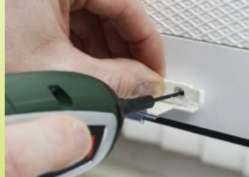
Abb. 6: Löcher am Fensterrahmen vorbohren
