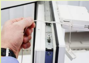
Abb. 23: Führen des Kabels nach außen
