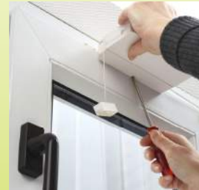
Abb. 43: Einrastung lösen
