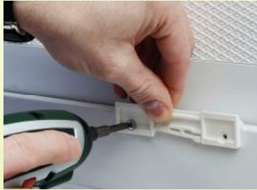
Abb. 3: Schrauben am Fensterflügel
