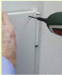
Abb. 15: Vorbohren für die Befestigung der Umlenk-Rolle
