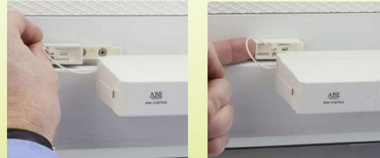
Abb. 12/13: Schieben des Clip (A1) auf die Fensterrahmen-Halterung
